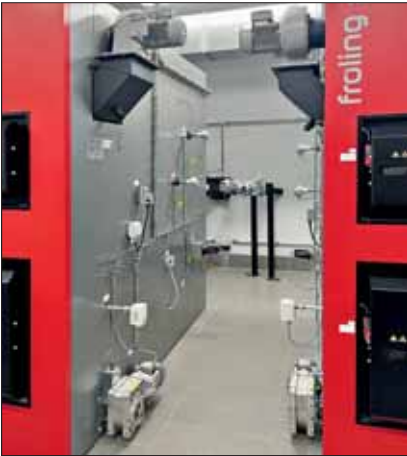
Die Trockenkammern werden mit Wärme aus der Hackschnitzel-Heizung betrieben, außerdem erzeugt man mit einer Vergaseranlage von Fröling Strom.
