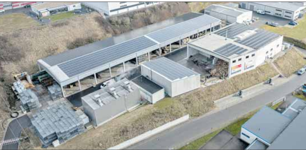
Das Brennholzwerk erzeugt klimafreundliche Brennstoffe und bemüht sich selbst um klimafreundliche Produktion: Neben den Solarzellen erzeugt eine Vergaseranlage mehr Strom, als in der Produktion benötigt wird. Überschüsse werden zum Beispiel zur Beladung von E-Fahrzeugen genutzt. Der Wärmebedarf der Anlage wird aus eigenen Holzresten gedeckt. Fotos: Weima (6), Brennholzwerk Trier (4)
